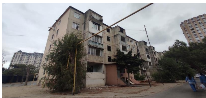
Şəkil 1. R.Rüstəmov küçəsində söküləcək 9 nömrəli binanın hesabətı [10]
