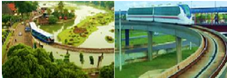
Şəkil 8. İndoneziyanın Cakarta şəhərində relslər üzərində işləyən avtomatlaşdırılmış pnevmatik nəqliyyat vasitələrinin işinə əsaslanan nəqliyyat xəttinin yerləşdiyi bir tema parkı
