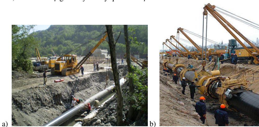
Şəkil 3. Qaz borularının xəndəklərə düzülməsi
