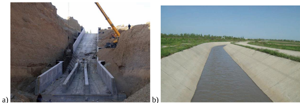
Şək.1. a- Tovuzçay su anbarında suburaxan qurğunun tikintisi, b- Xanarx kanalı
