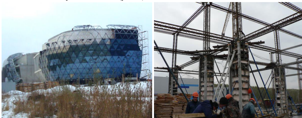
Рис. 5. Строительство здания технопарка
