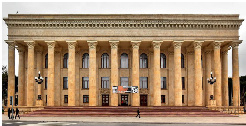
Şəkil 9. Nəfçilər prospektində muzeyin binası
