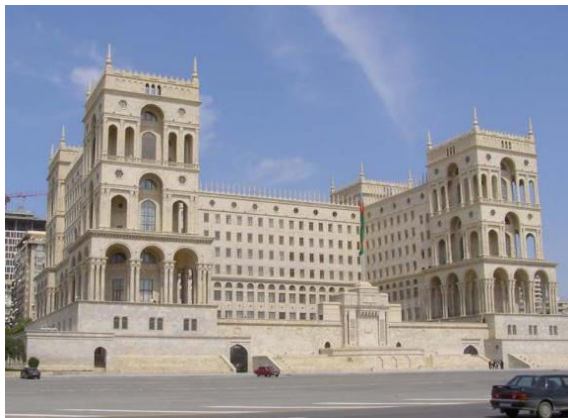
Şəkil 1 hökumət evinin binası
