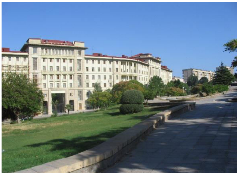
Şəkil 7. Keçmiş Mərkəzi Komitənin və Nazirlər Şurasının binası
