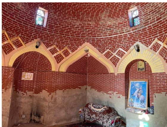
Şəkil 10. Kəngərli rayon Yaralı Sultan ocağı (Məhəmməd Bayramov).
