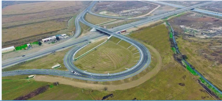
Şəkil 5. Yeni yol infrastrukturu [8]
