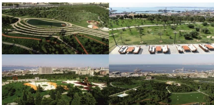
Şəkil 4. Bakı şəhəri, Sadıqcan və Əbilov küçələrinin kəsişməsində “Gənclik” parkı [10]
