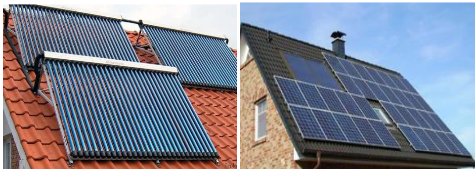
Şəkil 2. Günəş panelləri: borulu vakuümlü və fotovoltaiik
